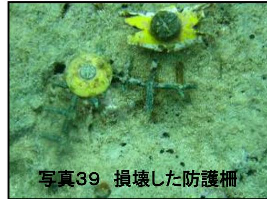
写真39 損壊した防護柵
